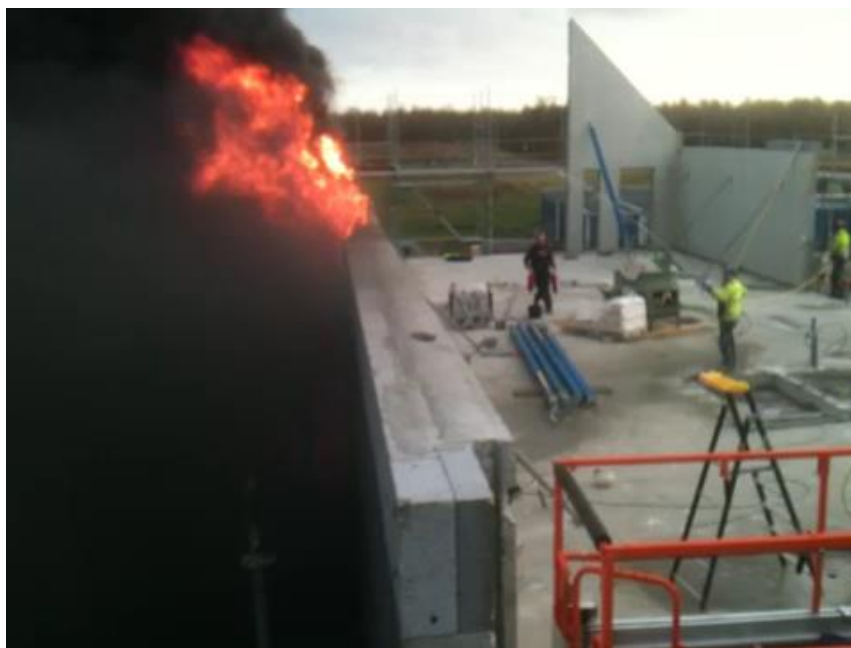
Figur 2 Brandtillbud i grafit-EPS i halvsandwichvägg under produktion. Lägg märke till den kraftiga rökutvecklingen – vinden driver röken bort från byggnaden – och att branden inte längre är möjlig att släcka med den utrustning som finns på platsen. Branden kommer snart att omfatta hela väggen. Foto: Skanska
